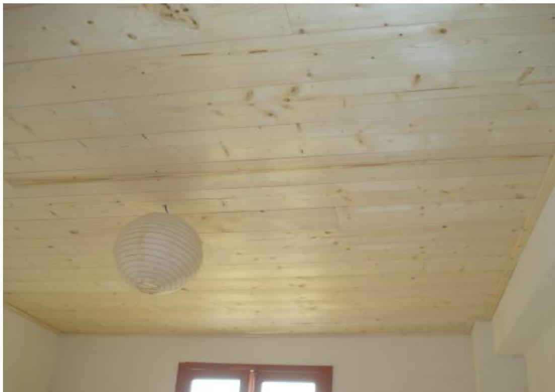
**COSYLAMES** : lame de parement en sapin du nord profil mini grain d'orge avec rainure décalée, brossée, rainée en bout, veinage assez fin, nœuds de forme et de taille variables avec une finition de teinte hydro-ciré. Le Cosylames est réservé pour un usage intérieur.
